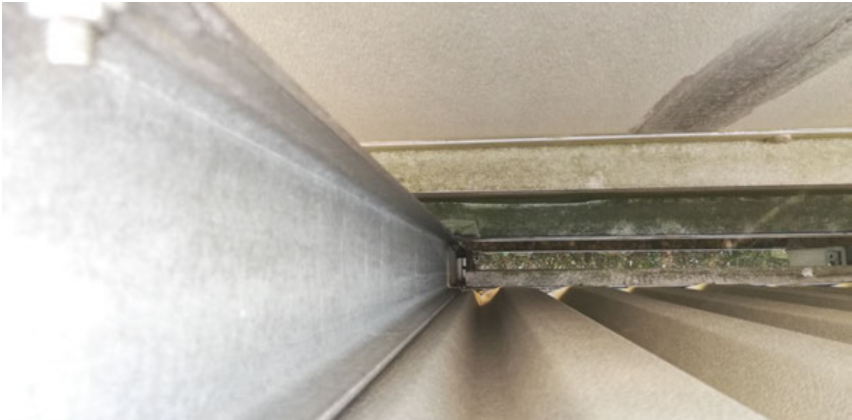
Dach Hauptbau _ Fassadenzwischenraum
