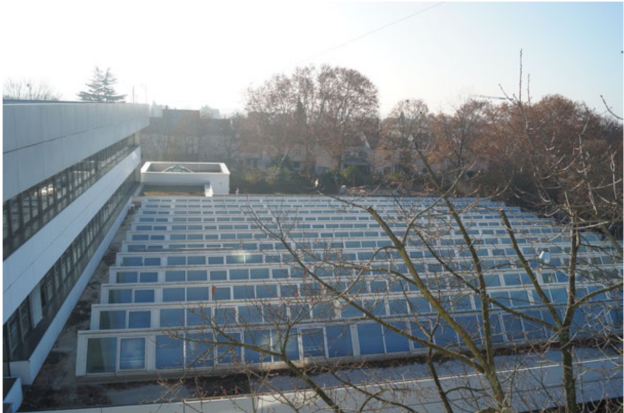
Dachfläche Naturwissenschaftlicher Trakt
